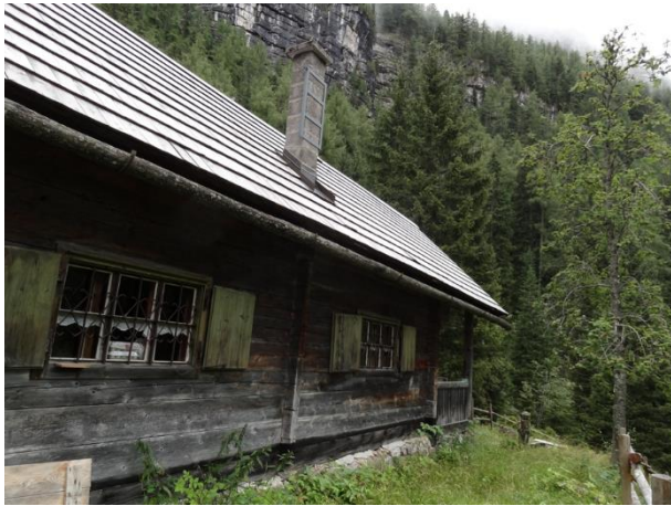
In diesem Bild finden sich die Lösungen zu zwei Herausforderungen, die der Aufenthalt in einer einsamen Jagdhütte im Nationalpark Gesäuse mit sich bringt.
